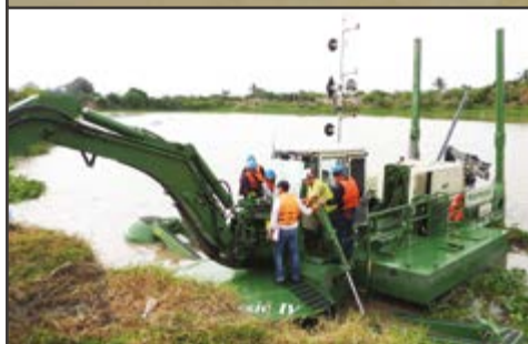
Сверху: очистка устья водозабора Снизу: обучение новых операторов
