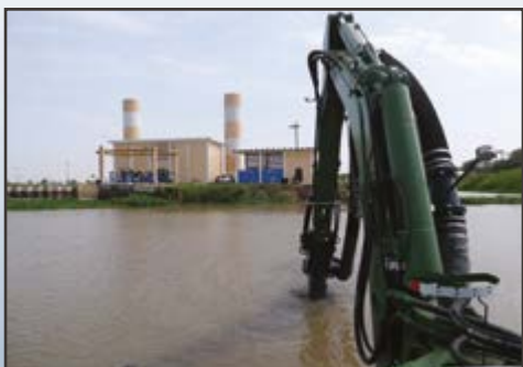
Дноуглубительные работы, производимые Watermaster рядом с водоочистным предприятием
