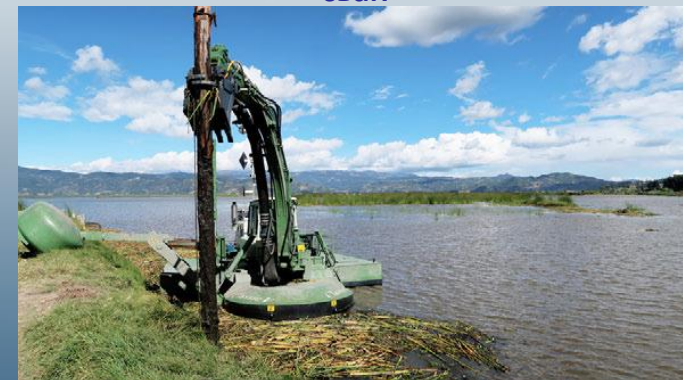
Укрепление береговой линии при помощи свай
